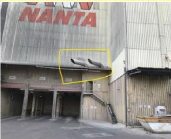
VISTA EXTERIOR - FOCOS 3,4 - SISTEMAS DE GRANULACIÓN
