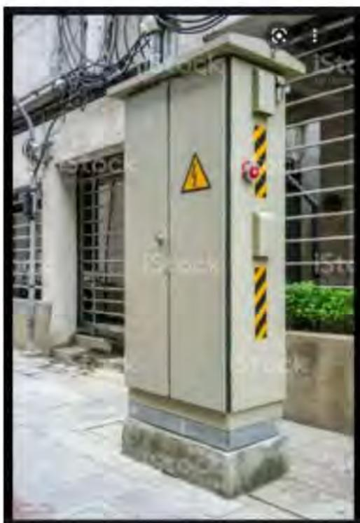
**Figura 3.** Ejemplo de armario con doble puerta que contiene el punto de medida.
