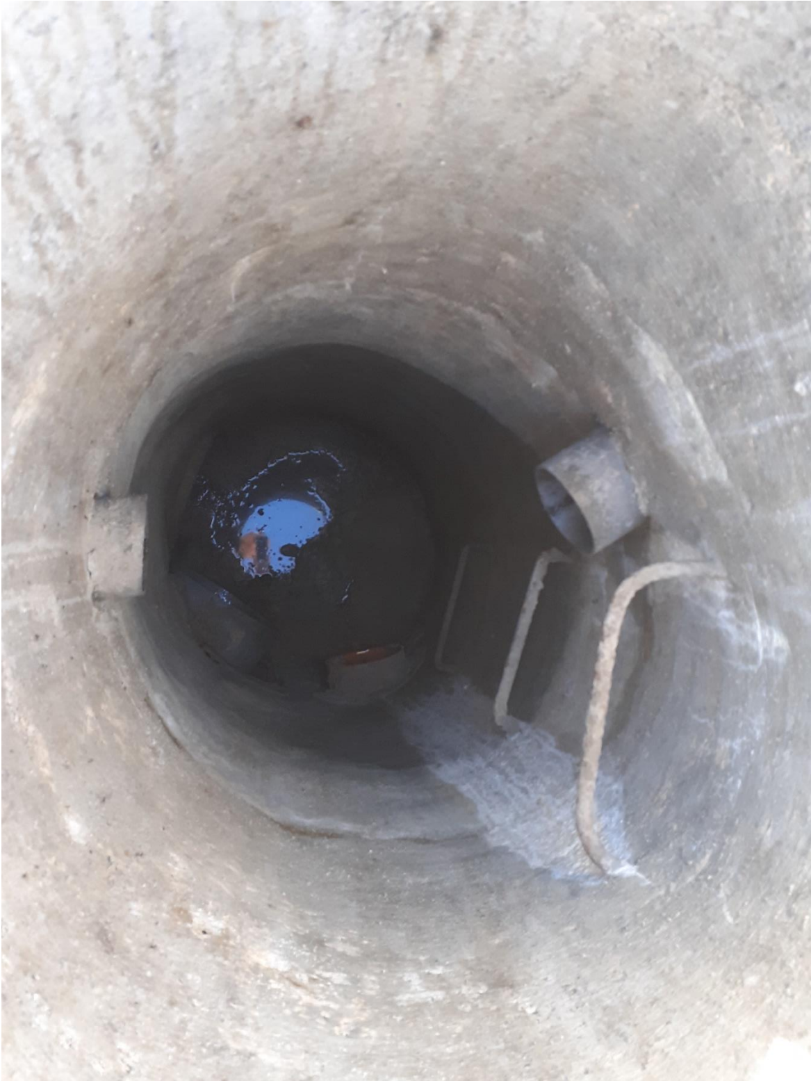
Fotografía 1. Pozo 1 (P1). Pozo de registro de aguas pluviales 1.
