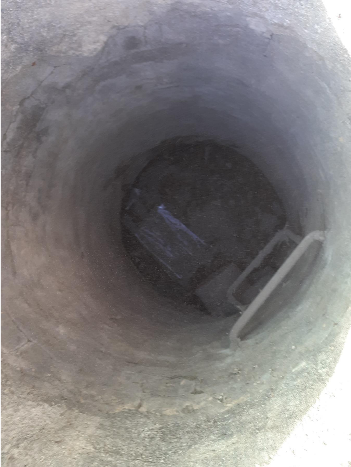
Fotografía 3. Pozo 2 (P3). Pozo de registro de aguas pluviales 2.
