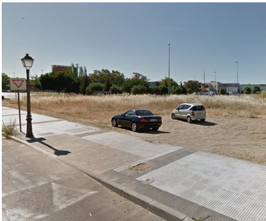
Ejemplo de paso de peatones que no cumple las condiciones de accesibilidad
