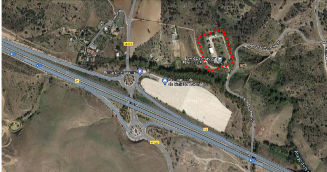
Vista aérea de la EDAR El Vellón, El Molar y Pedrezuela, en El Vellón.
