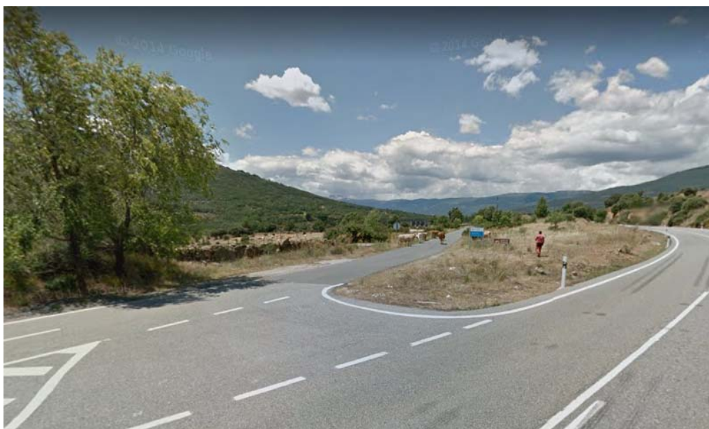
Fig. 5.10.3.3.- Desvío M-604 - acceso ETAP (Fuente: Street view google.)
