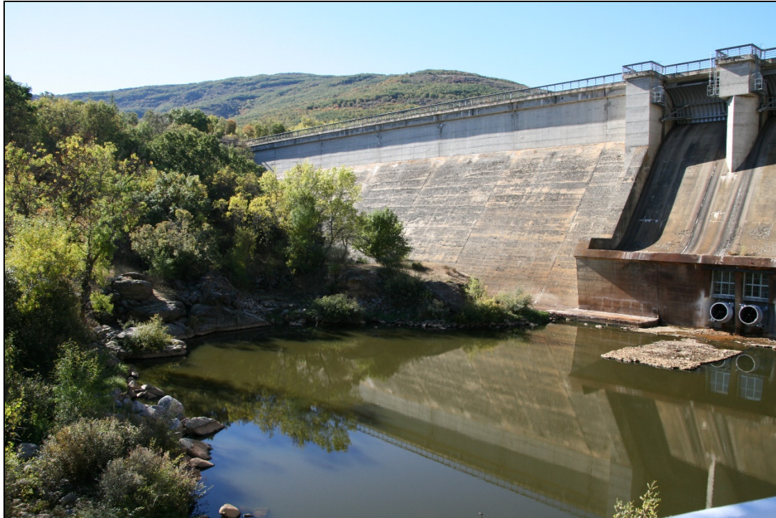
Figura 5.7.1.2 Fotografía de la presa del Embalse de La Pinilla en la que se observa parte de la vegetación de ribera.
