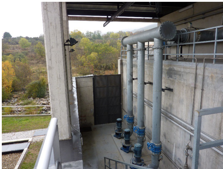
Figura 3.2.3.7.2.1.- Vista bombes sin cerramiento perimetral. (Fuente: Canal de Isabel II)
