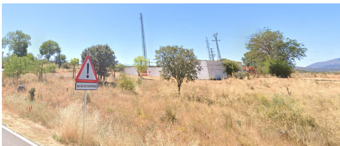
Fig. Vista de la subestación existente junto a la M-137 a la que se conectarán las PFVs
