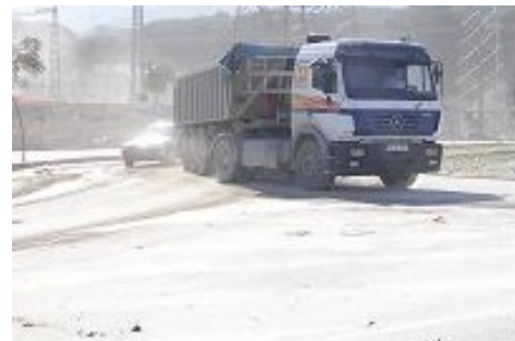
Partículas en suspensión por la circulación de camiones en una obra
