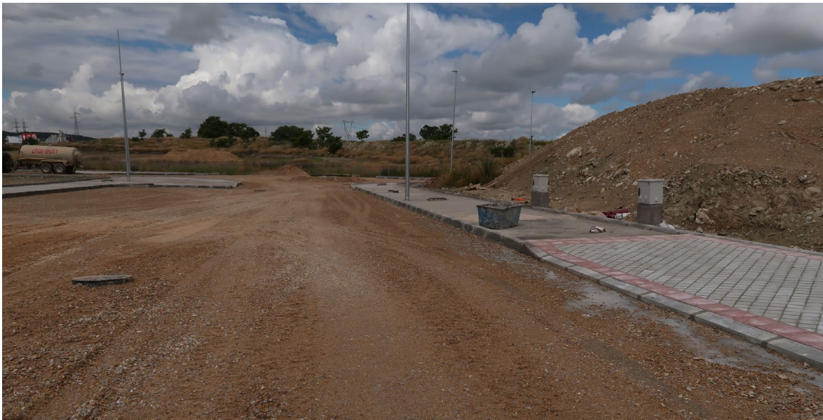
Figura 1.- En la siguiente imagen tomada en mayo de 2020 se ven un último plano el sector SURT-9 objeto de planificación y en primer plano el sector S-1 en proceso de urbanización
