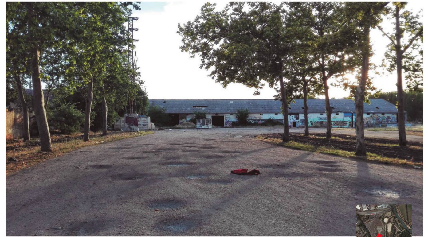
Calzada Sur del Paseo de Guardias Walonas hacia la Estación
