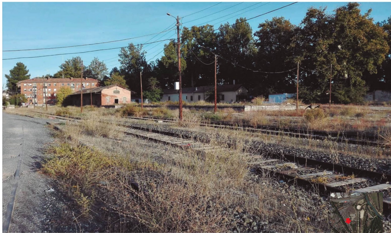
Emplazamiento de la primera Estación donde se aprecia el Muelle original de 1851
