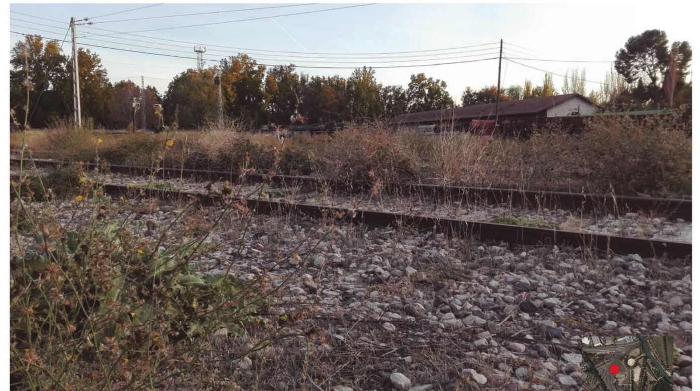
Playa de vías muertas con el Muelle de la Estación al fondo.
