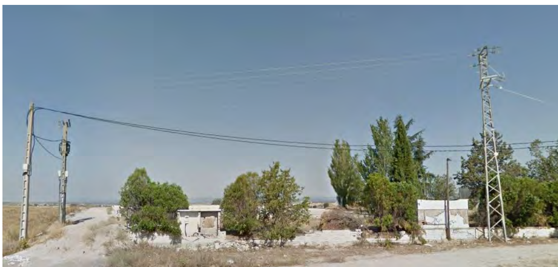
Figura 4.5.e Imagen de nave comercial / industrial. Imágenes de agosto 2012 (antes de su derribo) y junio 2015 (ya derribado) siendo este su estado actual
