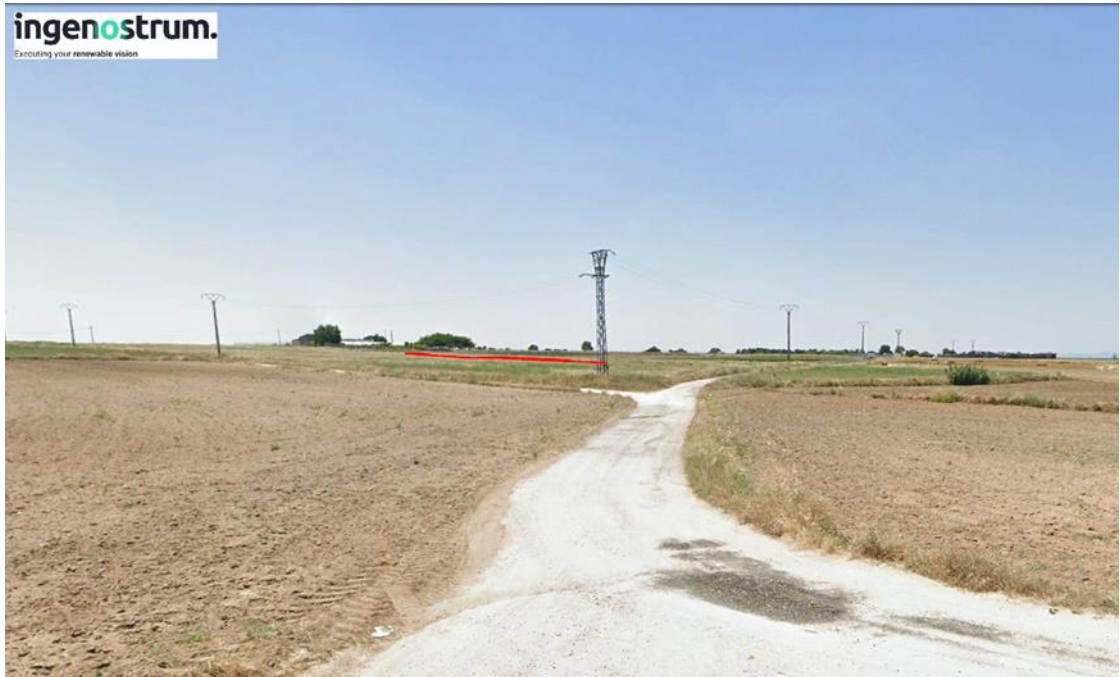
Figura 4.- Intersección Camino de los Leñeros
