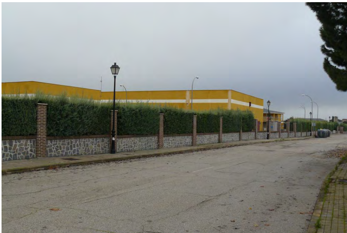
Figura 3.2.3.1.- Depósito de Griñón. (Fuente: Elaboración propia)
