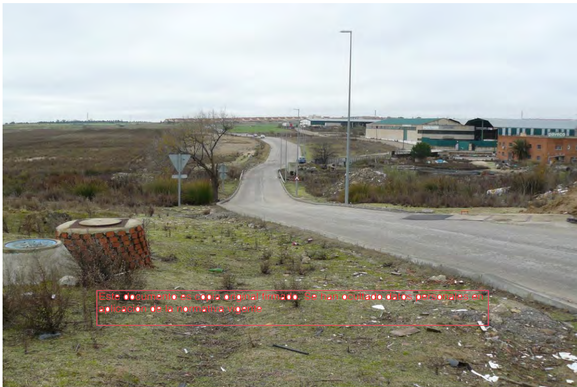
Figura 3.2.3.1.4.- Polígono industrial Las Arroyadas en Cubas de la Sagra. Cruce del subtramo a renovar a la altura de la luminaria. A la izquierda, pozos de registro de Canal de Isabel II.
