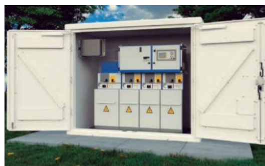
Imagen 11. Centro de seccionamiento tipo
