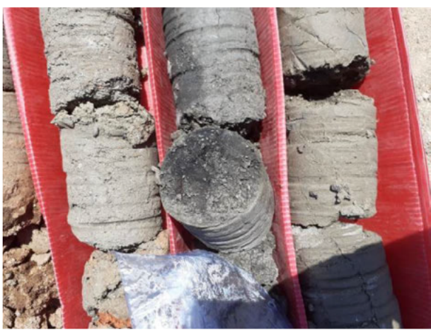
Foto 5. – Nivel afectado en S2 a 4 m
