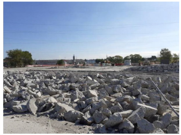
Foto 2. – Picado de la solera, vista hacia el Este
