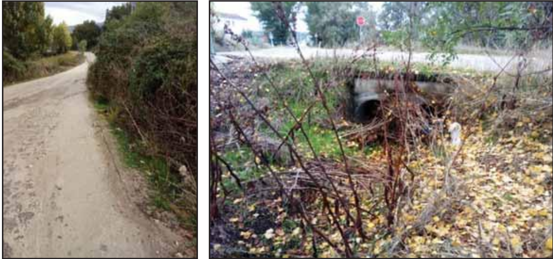
Figuras 26 y 27: Cuneta de la pista de acceso. Fuente: Elaboración propia.
