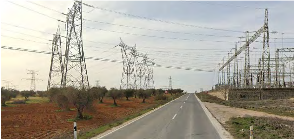
Paso de la Línea de Alta Tensión 132/220 kV ST-Mauricio-ST Morata Renovables en su tramo aéreo por encima de la M-313. Fuente: Google Earth Pro.
