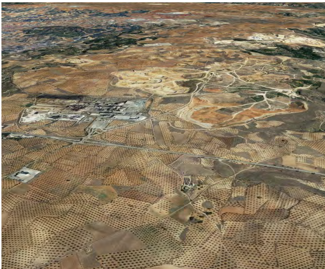
Entorno de LASAT 132/220 kV ST-Mauricio-ST Morata Renovables con vista hacia Morata de Tajuña . Fuente: Google Earth Pro.
