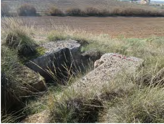
Vista del búnker desde el E
