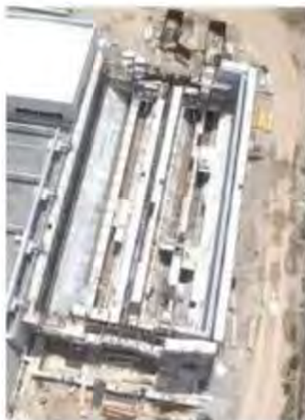
Figura 15. Imagen aérea obra civiles para dos reactores.
