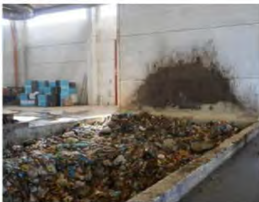
Figura 7. Foso de recepción
