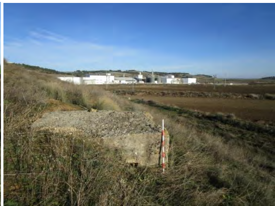
Foto 68. Búnker nº 1. Vista desde el S
