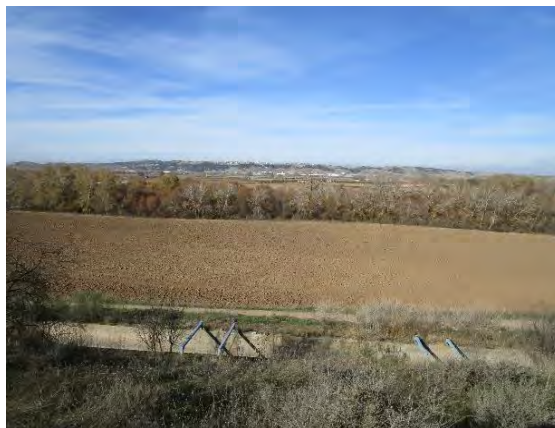
Foto 28. Pk. 1+650. Canal y río Tajo. Pk. final.
