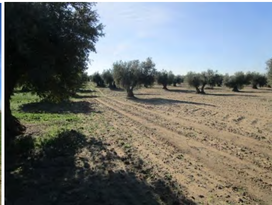
Foto 74. PK 5+500 hacia PK inicio
