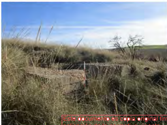
Vista del búnker desde el N
