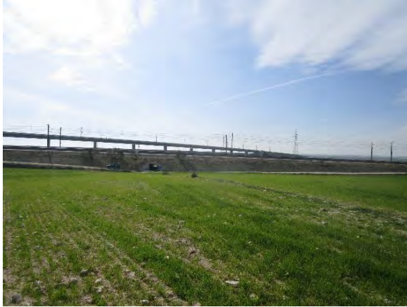
Foto 11. Pk. 5+000. Vista hacia Pk. origen.
