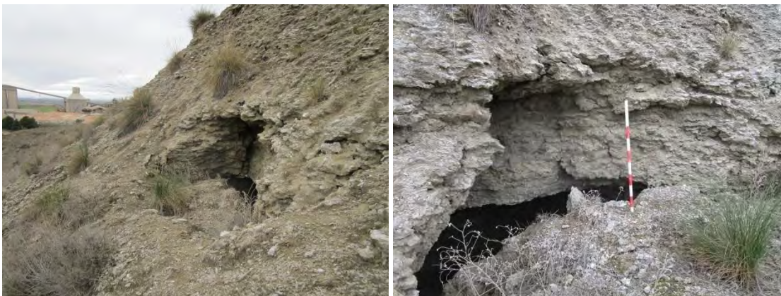
Dos viviendas destruidas por los derrumbes
