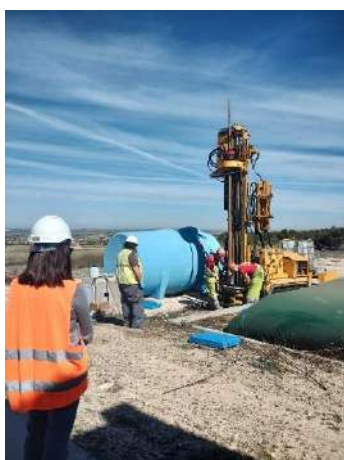
Figura 20. Ejemplo de máquina de sondeos y caja portatestigos.
