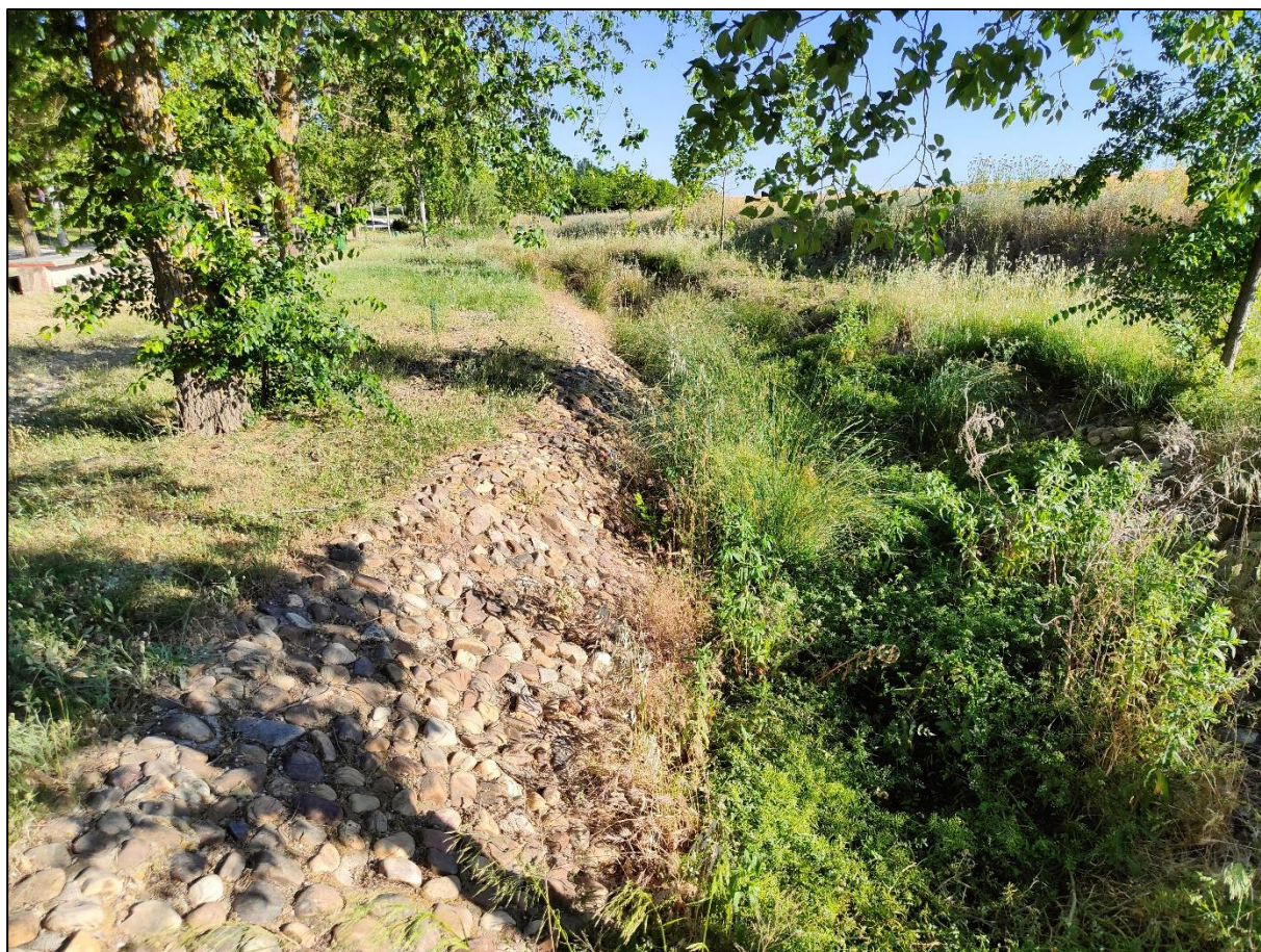
Ilustración 7. Fotografía 2. Arroyo Guaten en el tramo a la altura de la Ermita del Santo. Encauzado en una sección trapezoidal.
