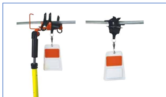
Imagen 36. Forma de colocación de la baliza salvapájaros, mediante pértiga.
