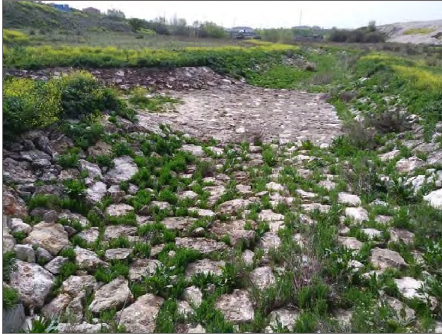
Imagen 15. Cauce artificial seco del arroyo de los Migueles (tesela 30). Hacia el ramal que sale a la izquierda confluye con uno de los colectores. Fuente: elaboración propia
