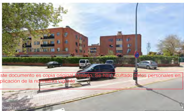
Fotografía 6. Ubicación aproximada centro de seccionamiento (punto final de la línea de evacuación)
