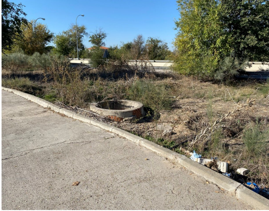
25 - POZO EXISTENTE ENTRE LA CARRETERA M-305 SENTIDO MADRID Y LA GLORIETA EXISTENTE
