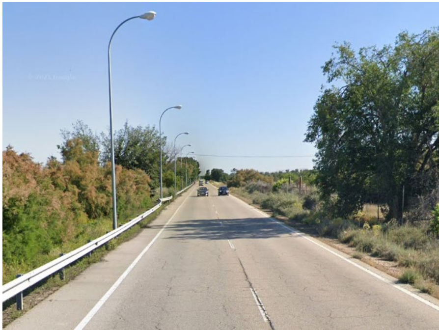
33 - CARRETERA M-305 SENTIDO MADRID - ARANJUEZ
