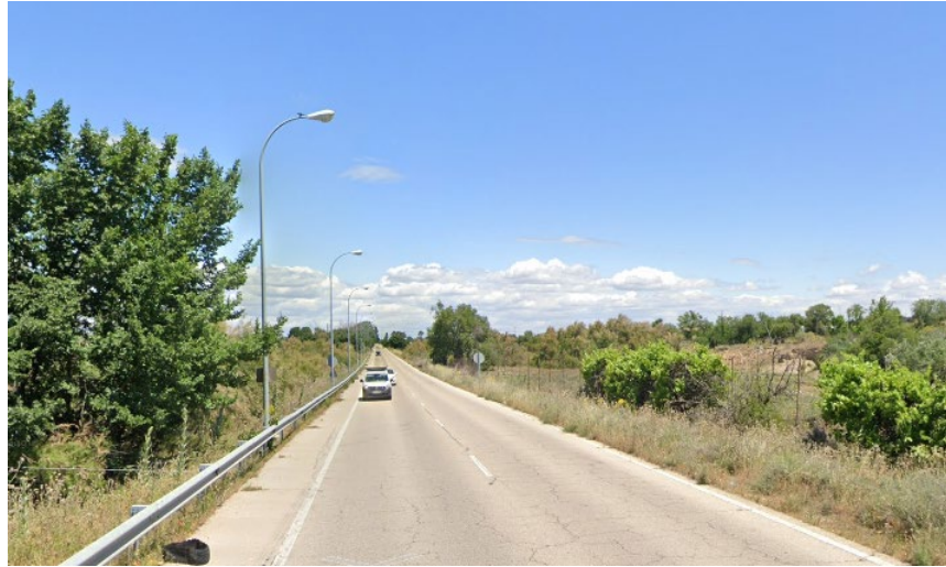
1 - CARRETERA M-305 SENTIDO MADRID - ARANJUEZ
