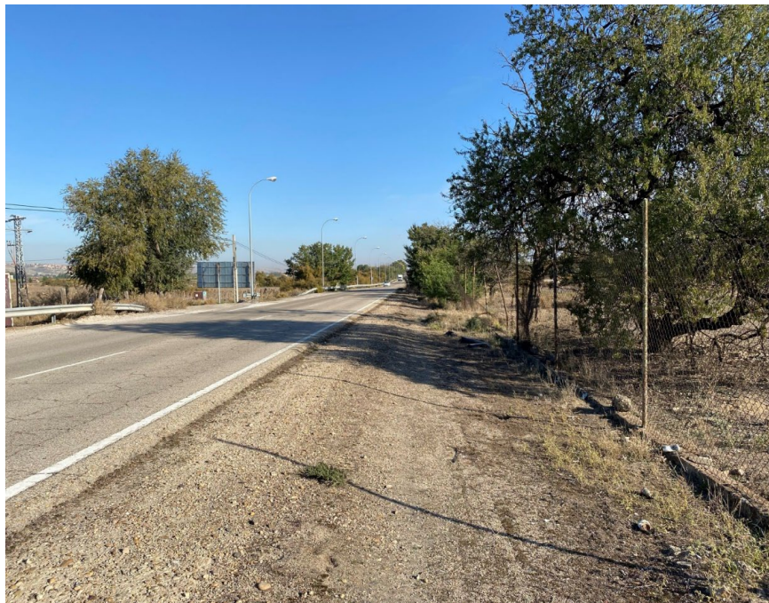
6 - CARRETERA M-305 SENTIDO MADRID - ARANJUEZ
