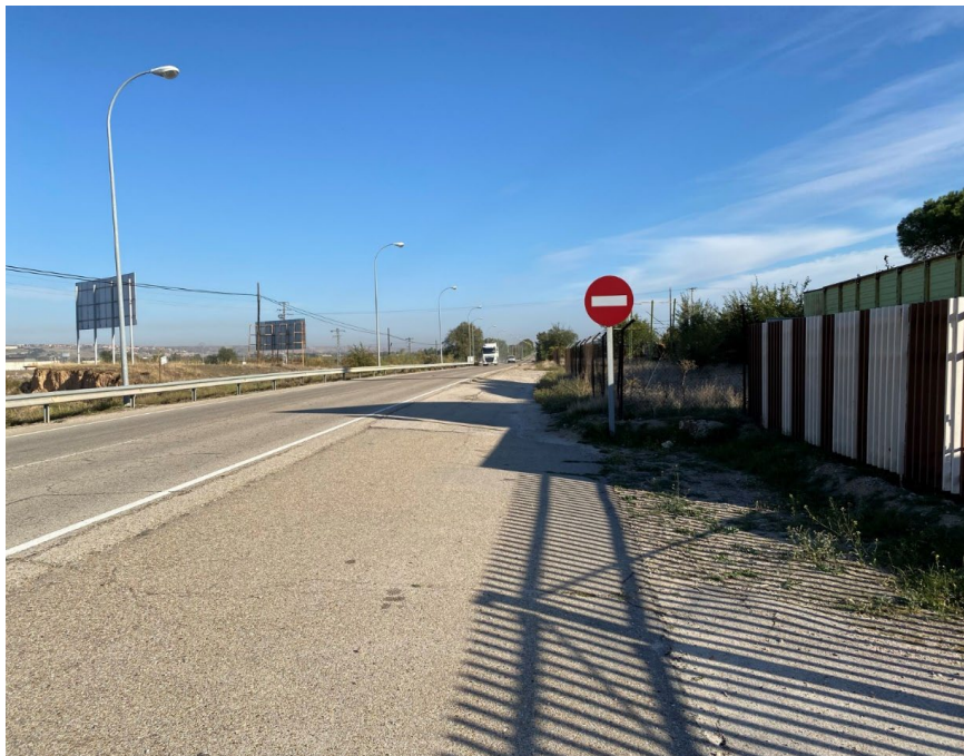
4- CARRETERA M-305 SENTIDO MADRID - ARANJUEZ
