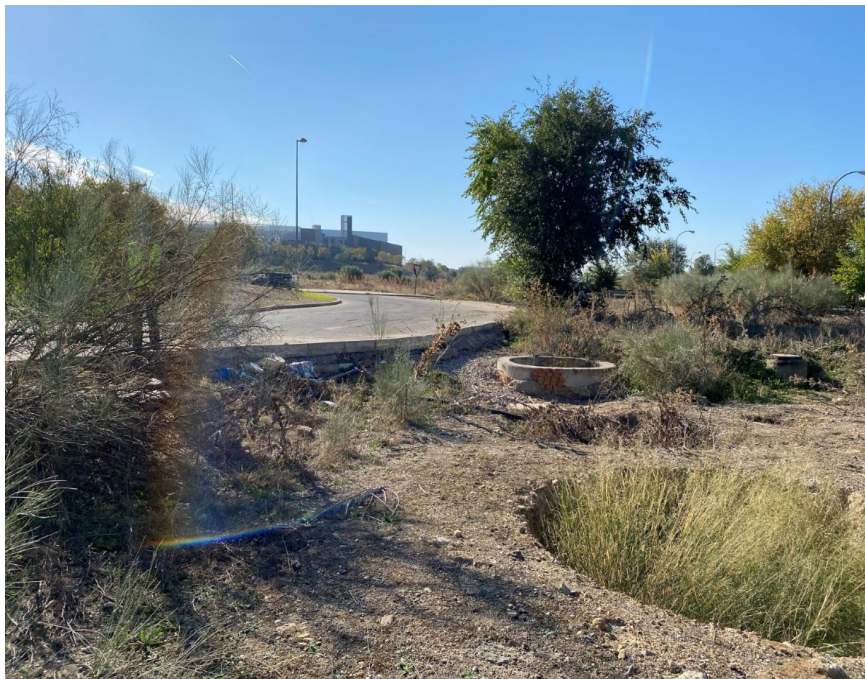
24 - POZO EXISTENTE ENTRE LA CARRETERA M-305 SENTIDO MADRID Y LA GLORIETA EXISTENTE
