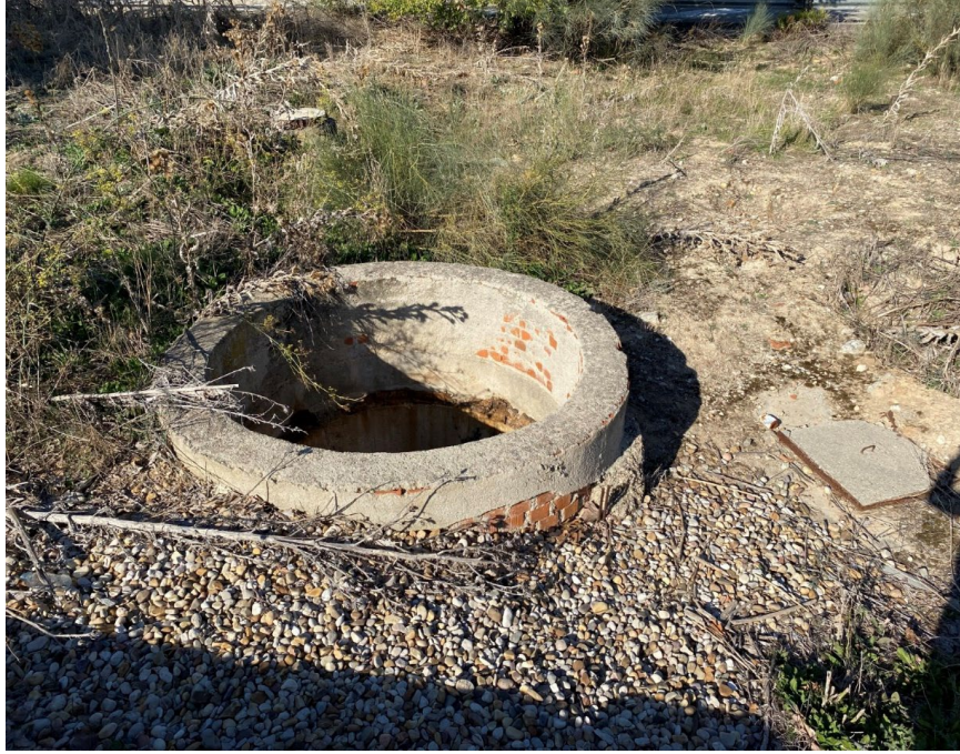
23 - POZO EXISTENTE ENTRE LA CARRETERA M-305 SENTIDO MADRID Y LA GLORIETA EXISTENTE
