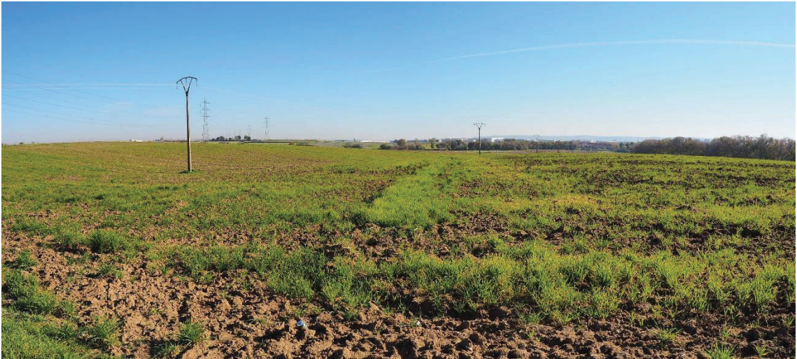
Foto 1. Entre el V-18 (apoyo 64) y V-19 (apoyo 66), en la zona de paralelismo con la LAT existente. Al fondo la zona de la A-42 (Dirección Madrid).
