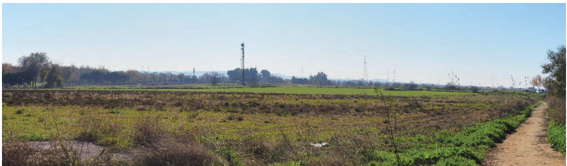
Foto 5. Zona de llegada al tramo subterráneo, con el parque a la izquierda (Comunidad de Madrid)
