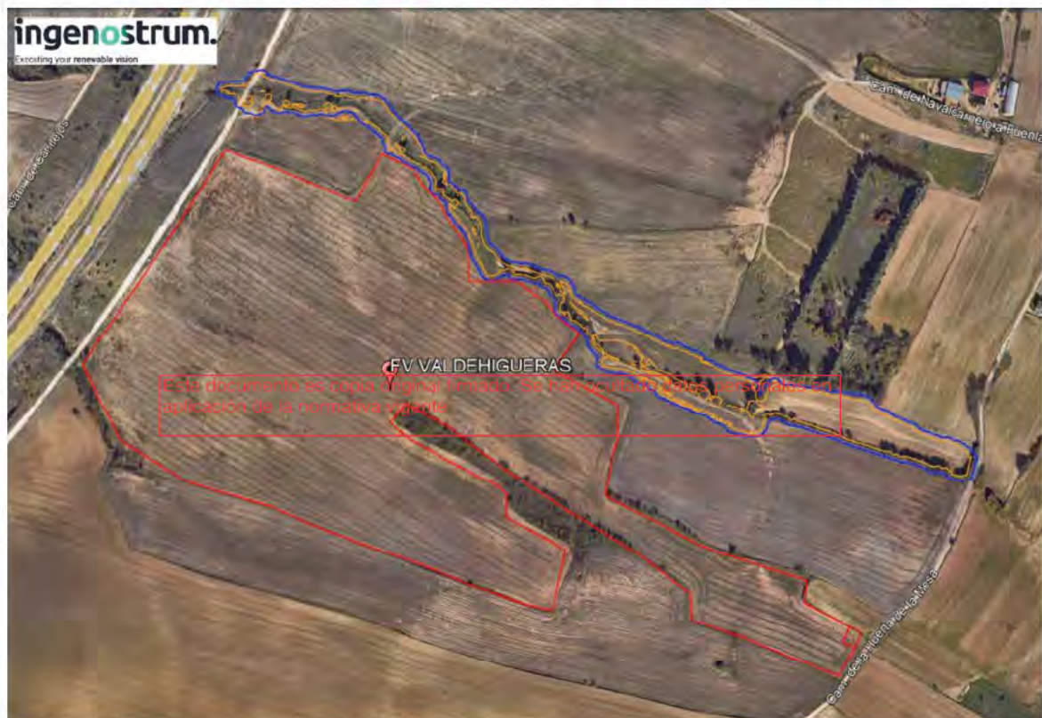
Figura 16.- Arroyo del Francés, T-500 (naranja) y DPH, próximo a la instalación.
