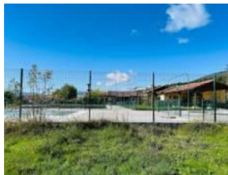
Fotografía 6. Vista de la zona norte, instalaciones principales de la piscina municipal
