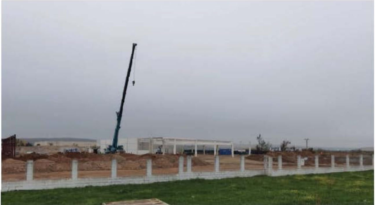
Vista de las antiguas instalaciones de Toyota donde se están llevando a cabo en la actualidad movimientos de tierras. Fuente: elaboración propia. Fotografía tomada el día 16 de noviembre de 2023.
