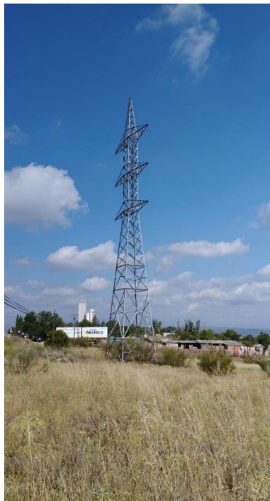
Figura 67. Torre de alta tensión en el interior del ámbito.
