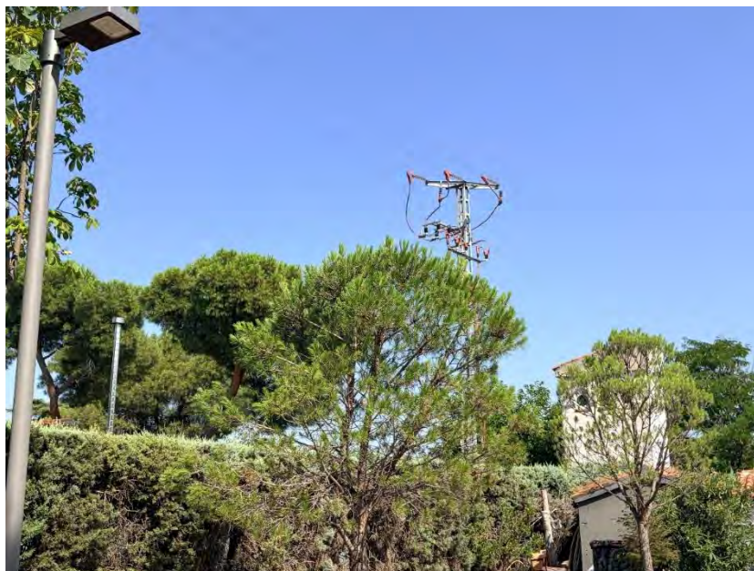
Figura 19. Línea eléctrica fuera de la parcela.
