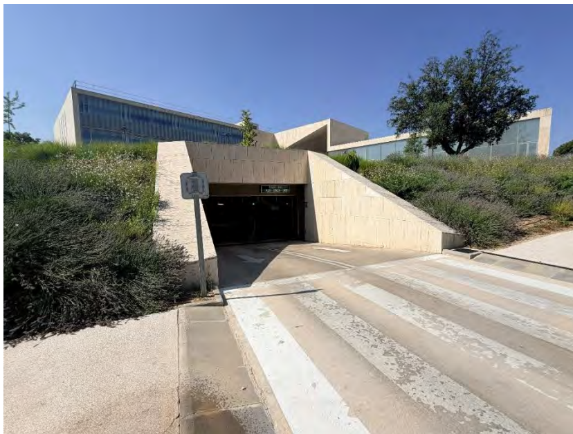
Figura 12. Acceso al aparcamiento.
