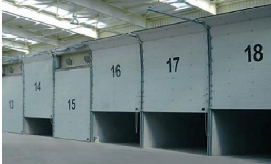
Ilustración 9. Túneles de compostaje. [Fuente: Mercadock]
