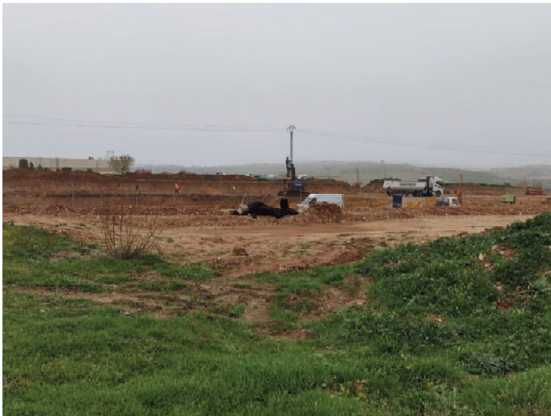
Figura 5: Estado del SAU 8 en noviembre de 2023. Fuente: visita de campo
