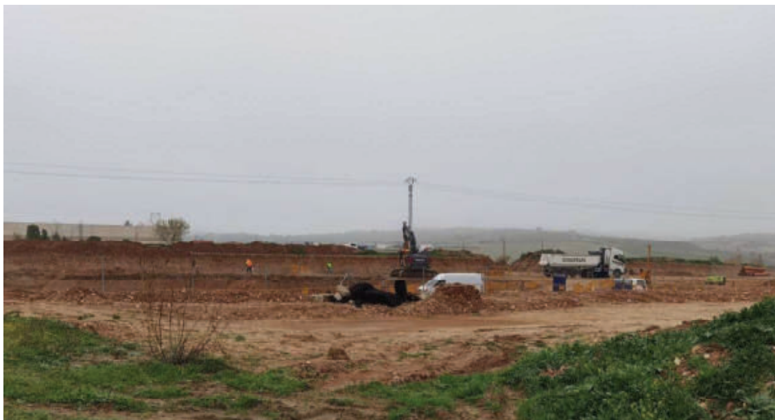
Figura 19: Situación de las obras en noviembre de 2023
