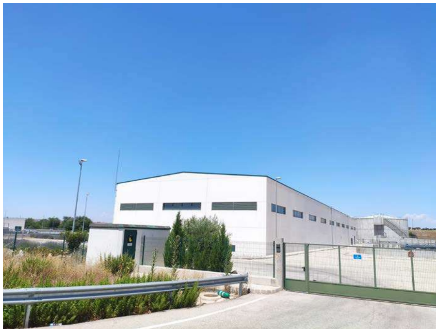
Figura 18. Edificación nº 4. Fotografía de la fachada asociada a las construcciones (Fuente: Elaboración propia).
