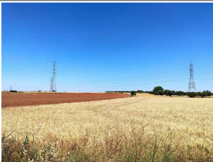
Vista de la parcela donde se localiza la base del apoyo
