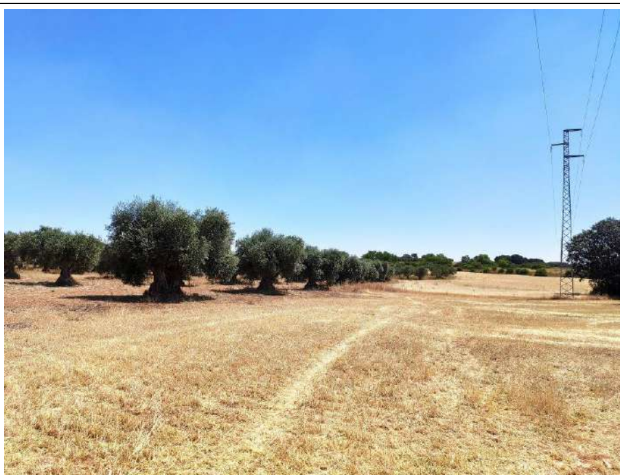
Vista del acceso campo a través y olivar donde se localiza la base del apoyo
