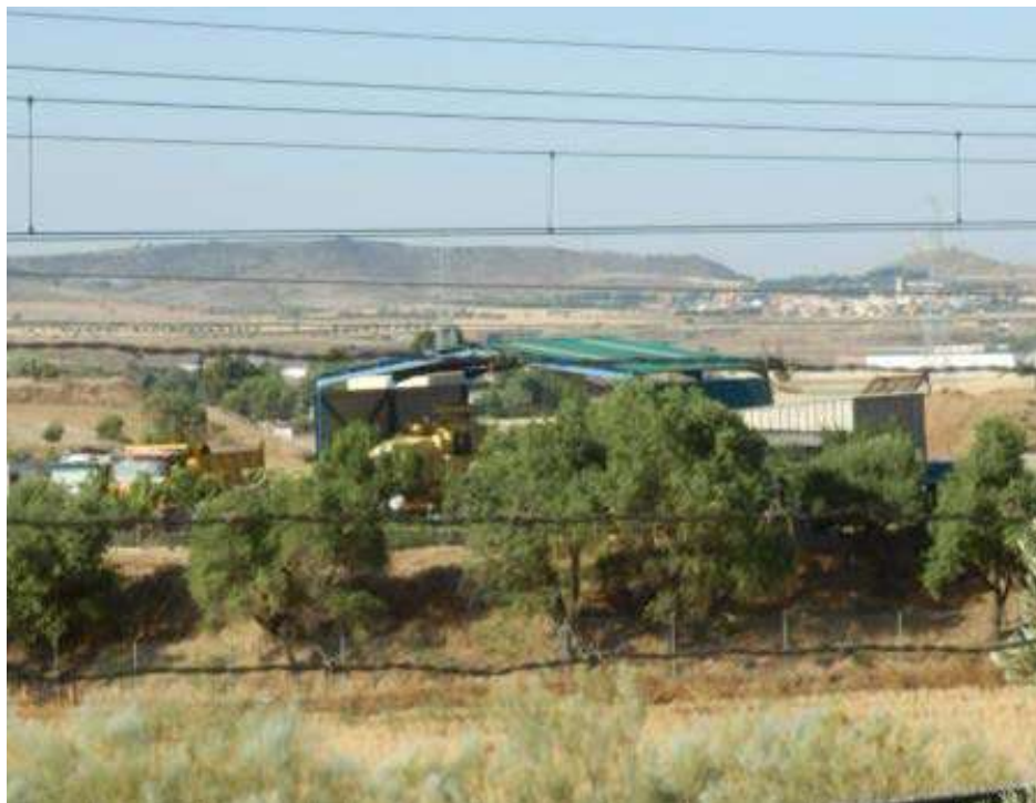
Figura 24. Edificación nº 6. Fotografía de la fachada asociada a las construcciones (Fuente: www.sedecatastro.gob.es )
