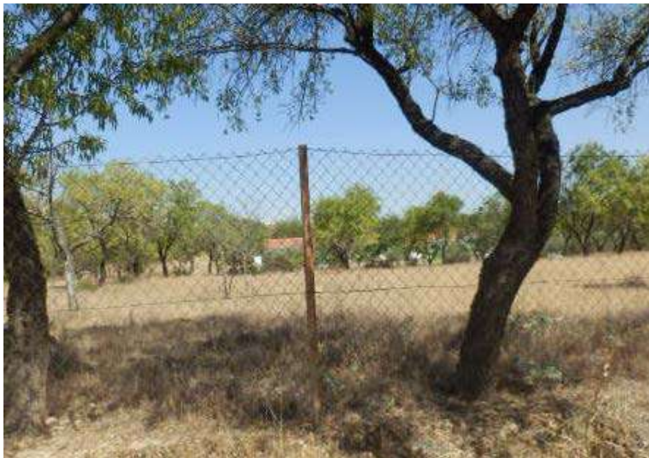
Figura 21. Edificación nº 5. Fotografía de la fachada asociada a las construcciones (Fuente: www.sedecatastro.gob.es )
