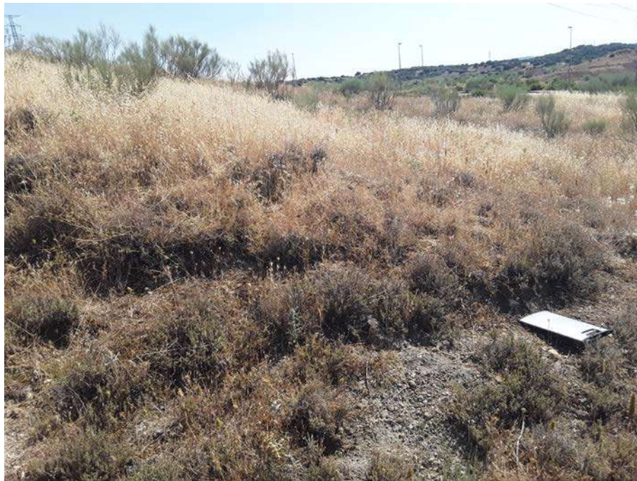
Vista de detalle de la base del apoyo
