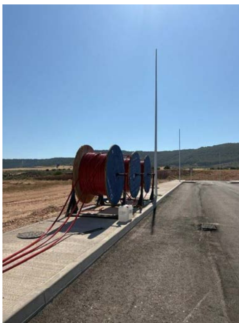
Ejemplo de tendido de cables eléctricos.
