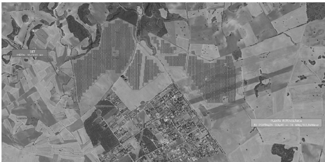
Figura 3. Vista de la planta fotovoltaica FV Portalón Solar.
