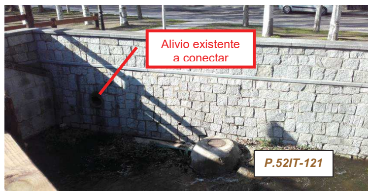
Fig. 7: Pozo de conexión de la red proyectada con la existente
