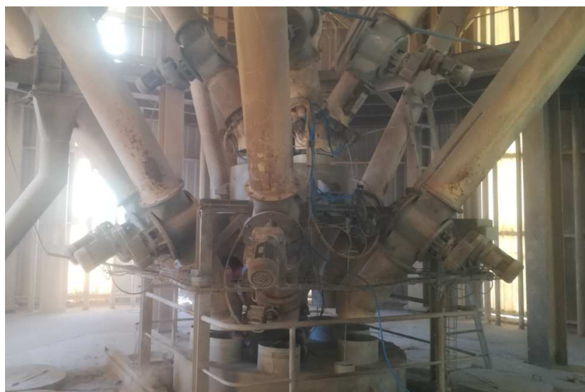
Fotografía 3.- Dosificación y Pesaje.
