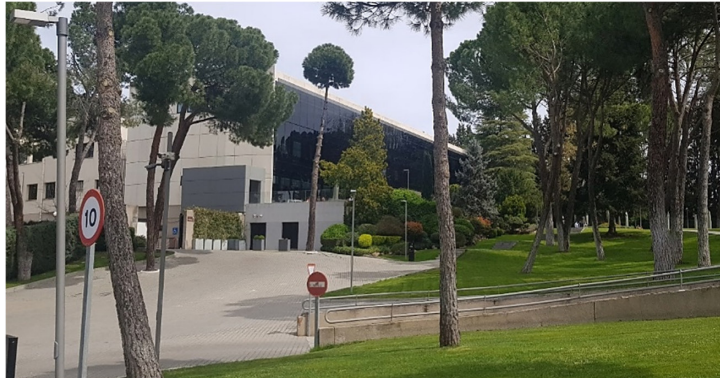
Edificio Máster, situado en la parcela nº 3 del Camino del Cerro del Águila
