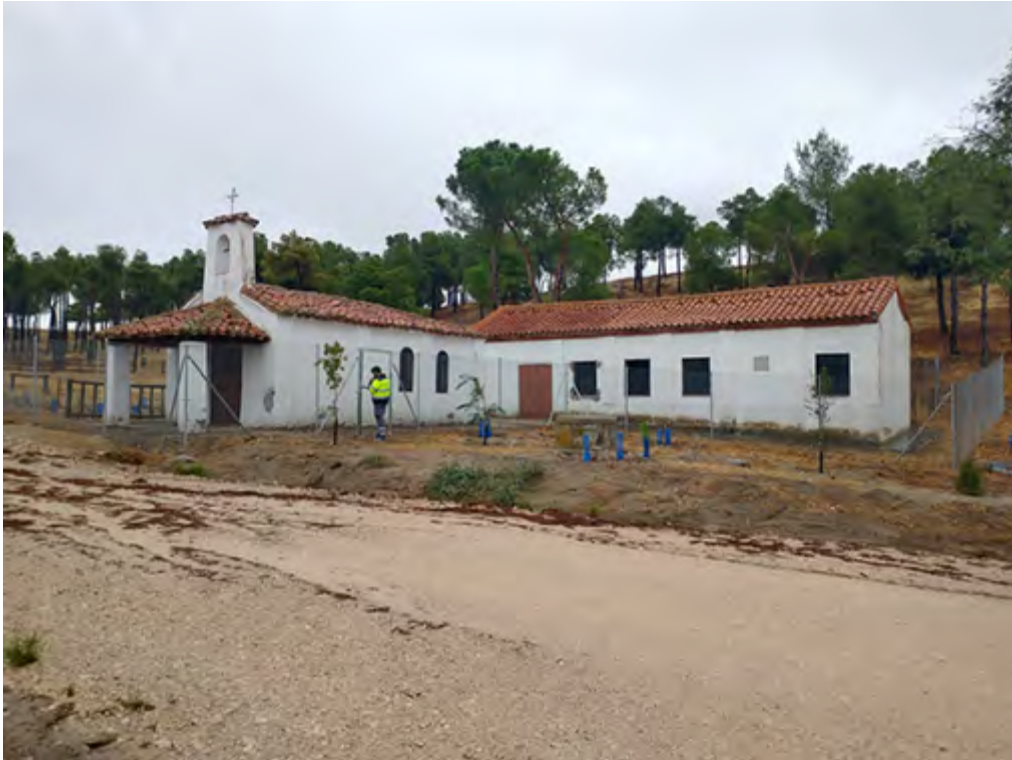
Vista general ermita / nave desde el sur
