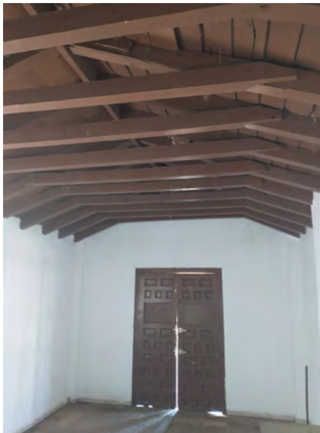
Vista interior ermita hacia puerta acceso
