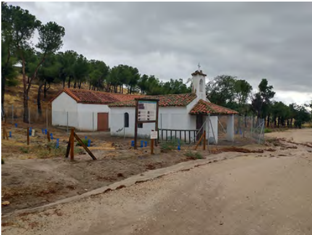
Vista general ermita / nave desde el norte
