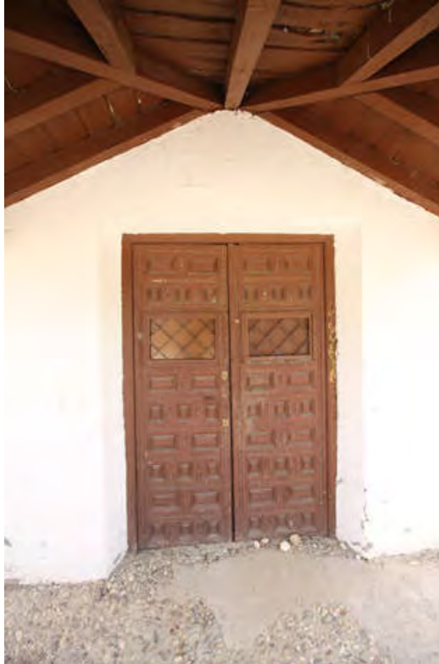
Vista puerta acceso en porche
