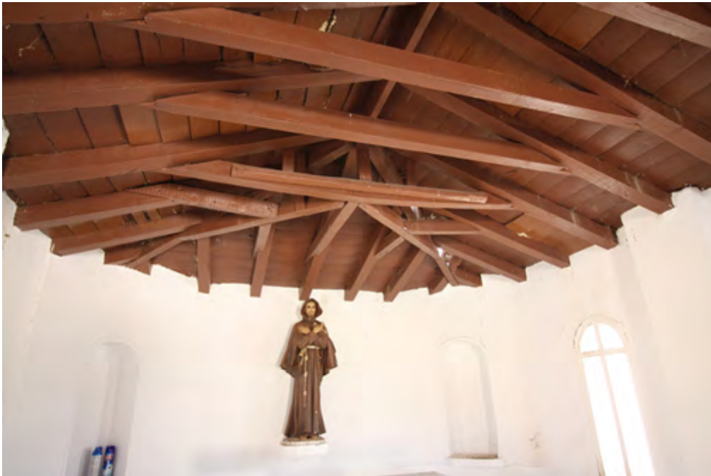
Vista cubierta y "ábside"
