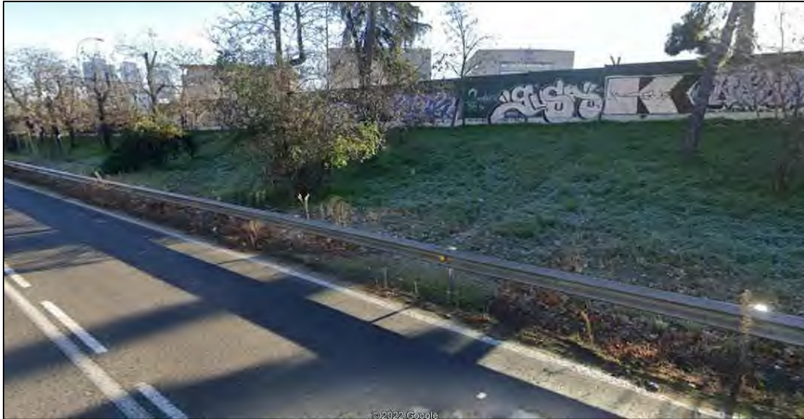
Ilustración 7. Aliviadero Alameda. Ubicación (Fuente: Google Earth).
