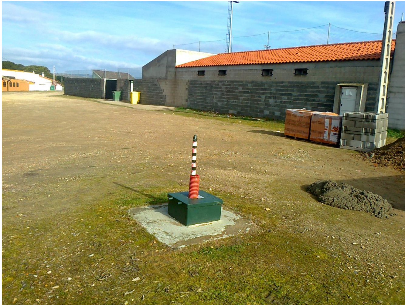
Foto 3. Detalle del hito de señalización del piezómetro 03.04.004 junto al campo de futbol municipal en enero de 2017
