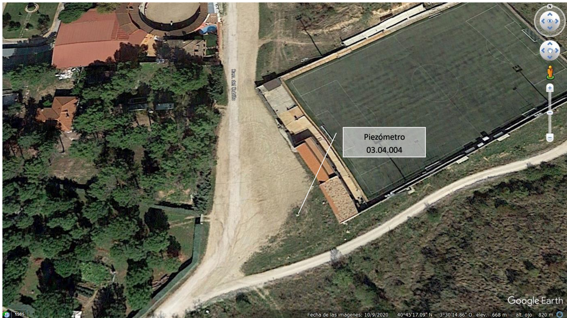
Foto 1. Imagen aérea de la localización del piezómetro 03.04.004
