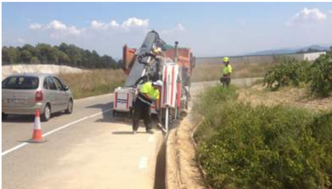
Img 13. Imágenes de ejemplo de máquina zanjadora trabajando y realizando minizanja.
