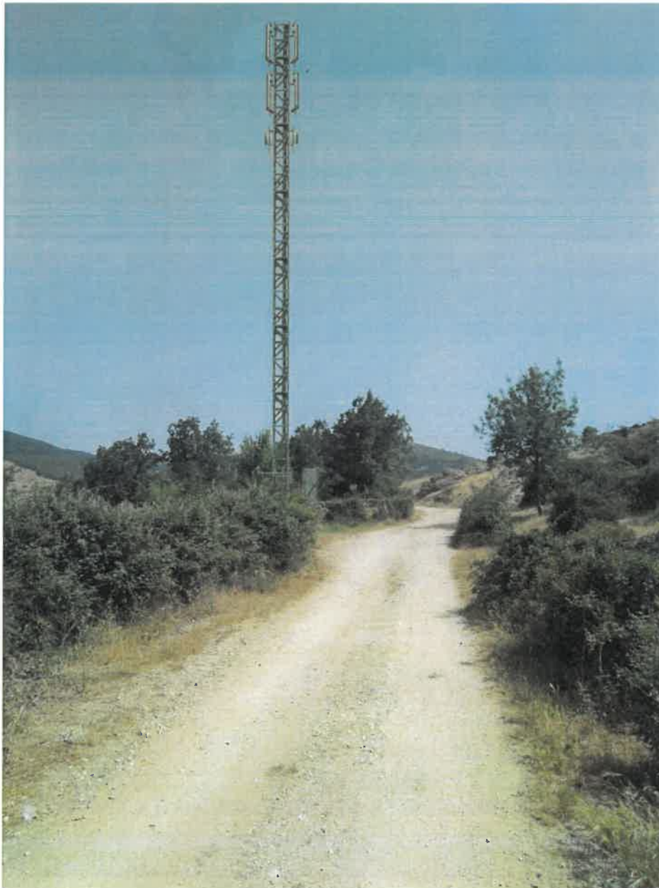
Foto 1B. Vista después de la instalación.
