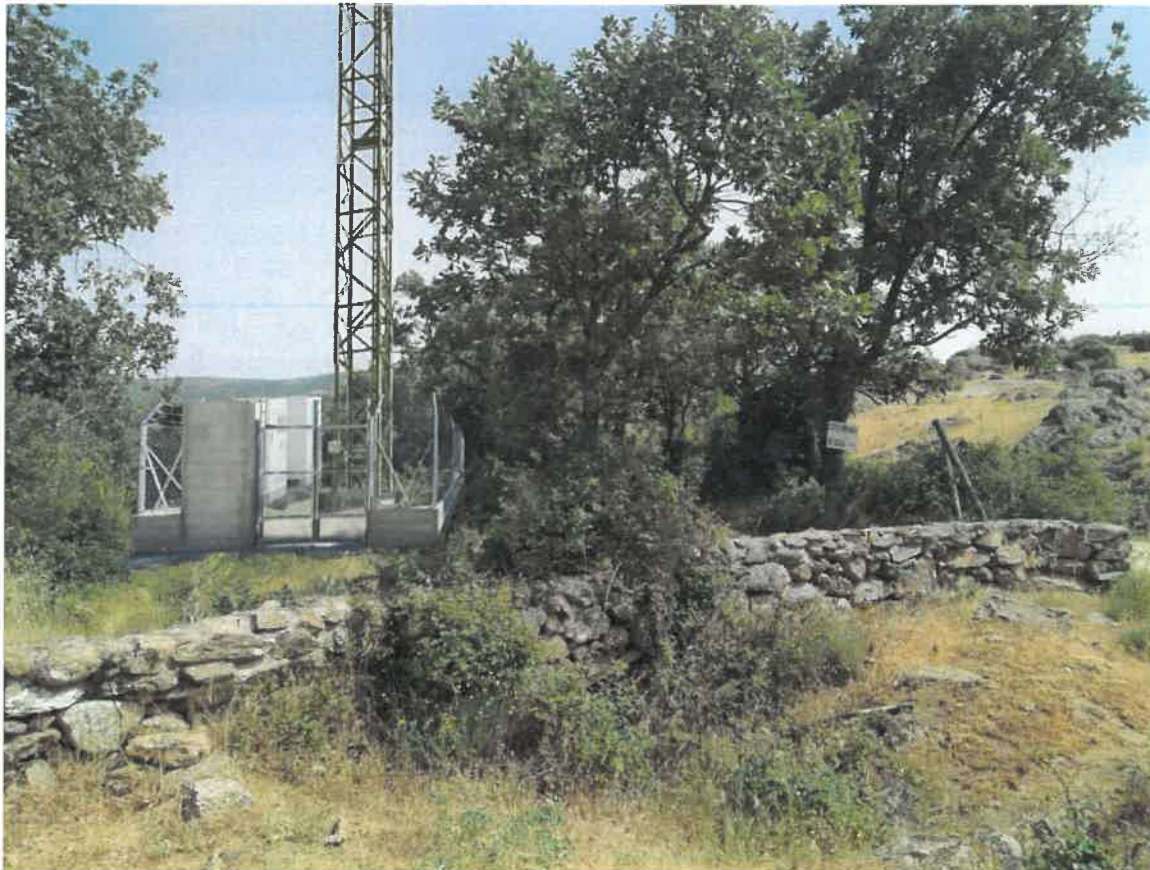
Foto 4B. Vista después de la instalación.
