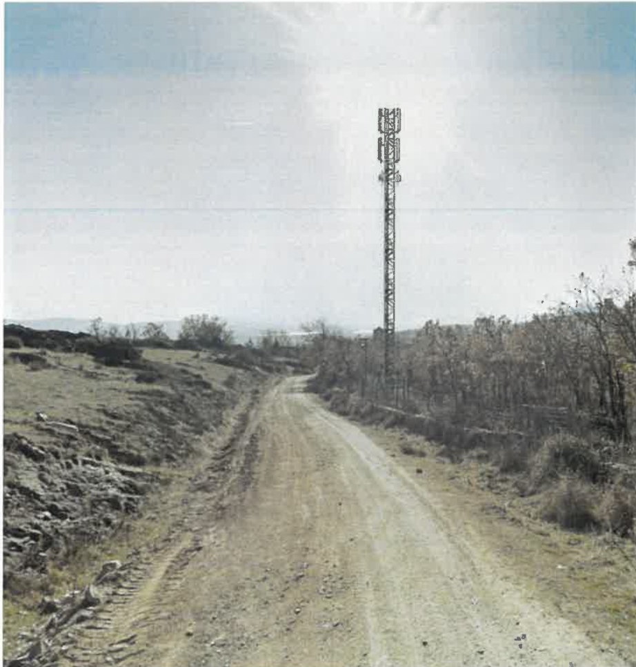
Foto 2B. Vista después de la instalación.
