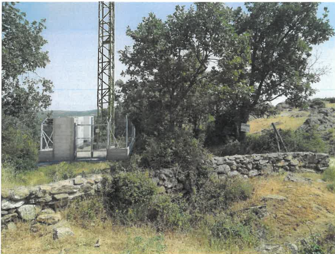
Foto 4B. Vista después de la instalación.
