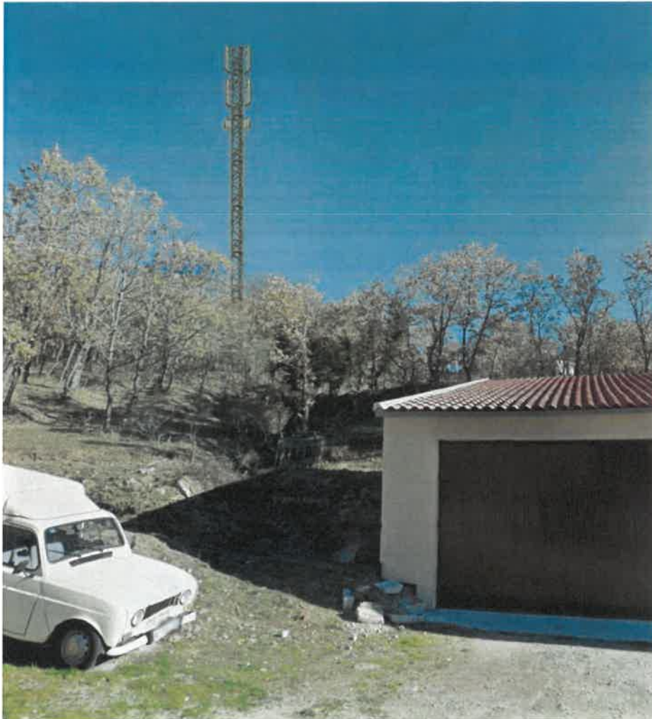
Foto 3B. Vista después de la instalación.
