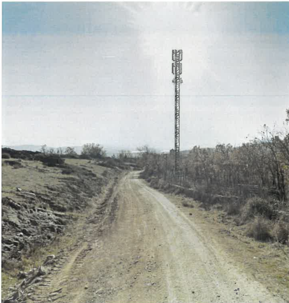
Foto 2B. Vista después de la instalación.
