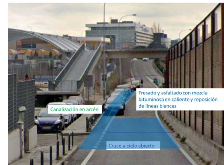
Figura 9: Canalización en arcén de Vía de los Poblados en PK 5+350
