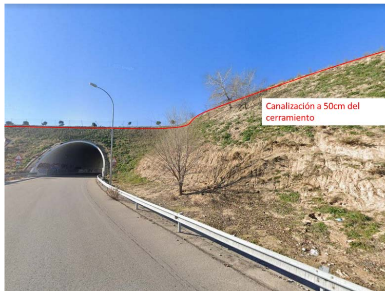
Figura 4: Canalización sobre la montera del túnel del mirador de Sanchinarro
