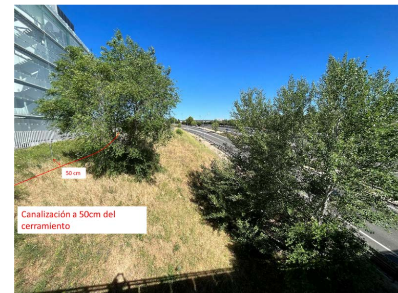
Figura 3: Canalización junto a cerramiento en PK 1+000
