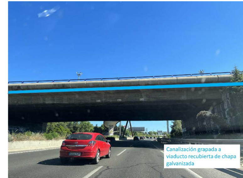
Figura 2: Cruce de la estructura sobre la A-1, PK 0+000
