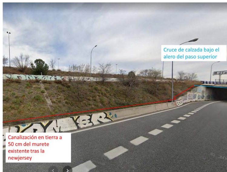
Figura 11: Canalizaciones en el entorno del enlace con la M-12 PK 8+000
