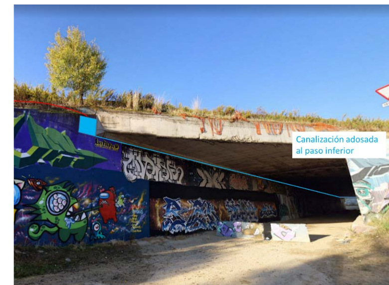
Figura 6: Canalización bajo el paso inferior en el PK 3+500
