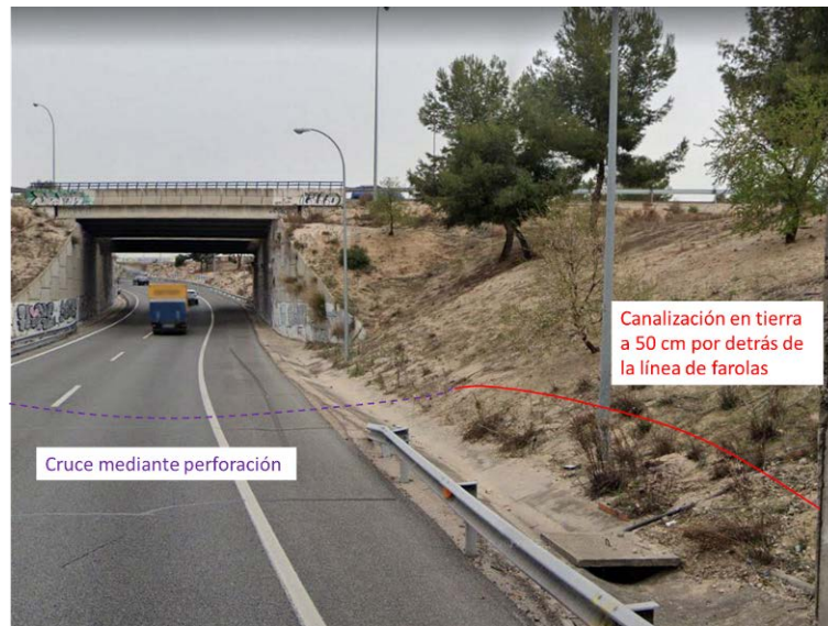
Figura 7: Cruce de vía de salida de M-40 a M-11 mediante topo en PK 3+900
