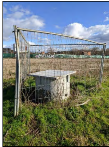
Fotografía 1. Pozo de agua situado en el interior del Sector.
